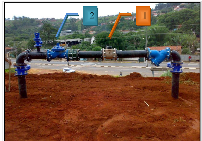
Figura 12. Entrada de água no DMC CDHU (detalhe 1-Macromedidor/2-VRP). Fonte: Sabesp (2008)
